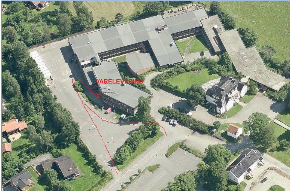
Bilde 7 - - Varelevering på Drengrud (kilde: Asker kommune/GISLine og befarng)
